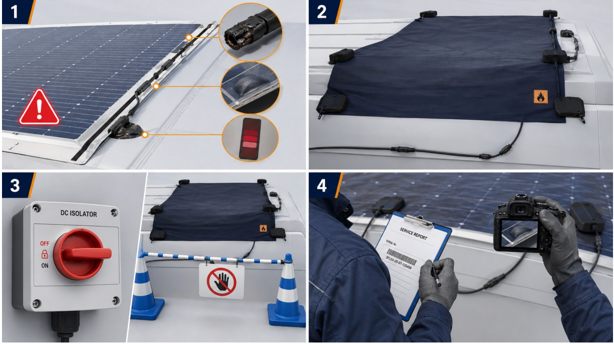
Şekil 7 - Arıza belirtisinde güvenli süreç: yaklaşımdan inceleme, ışığı güvenli örtüyle kesme, DC ayırıcıyla kapatma ve servis kaydı oluşturma.
